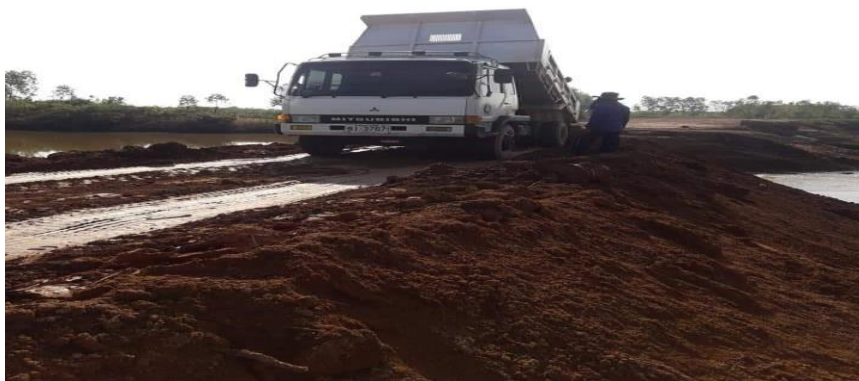
ภาพที่ 4.5 การทำคูไพรถกันน้ำเพื่อการเกษตรที่ฟุ้งหลายทุกปี
